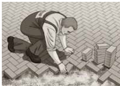
Мощение поверхности с формированием узора «елочка».
