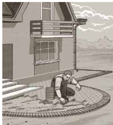
Укладка очередных рядов клинкерной брусчатки.
