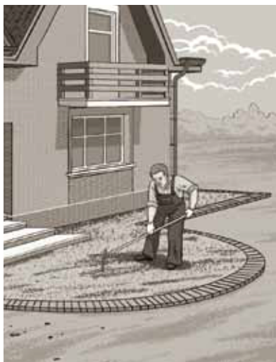
Укладка очередных рядов клинкерной брусчатки.
