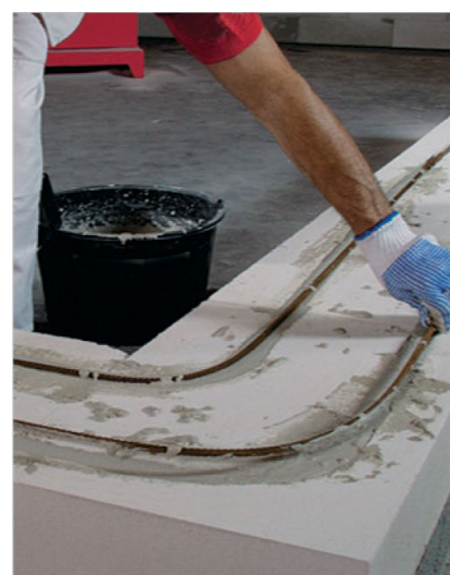
Рис. 5.18 В заполненные штробы вдавите арматуру. Излишки клея (раствора) удалите (рис. 5.18).
