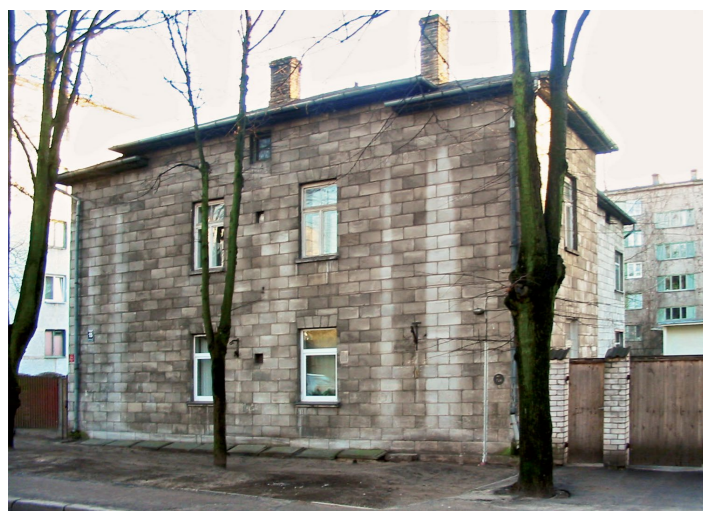
Здание из автоклавного газобетона без наружной отделки. 1939 г.п., г. Рига, ул. Эльвирас, 15
