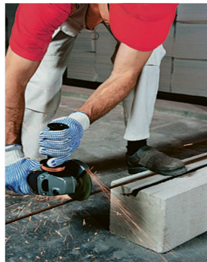
Рис. 5.16 Для укладки в штробы лучше всего использовать арматуру периодического профиля \varnothing 8 мм (рис. 5.16).
