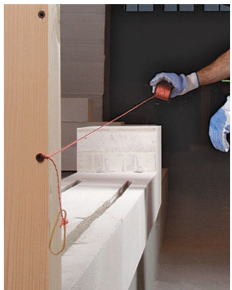
Между порядовками натяните шнур-причалку, по которому будет вестись кладка следующего ряда (рис. 5.25).
