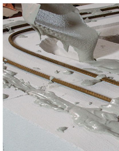
Рис. 5.17 Перед укладкой арматуры штробы следует заполнить клеем ЛСР или цементно-песчаным раствором. Это обеспечит совместную работу арматуры с кладкой и защитит арматуру от коррозии (рис. 5.17).
