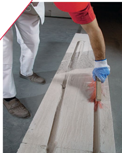
Рис. 5.15 Нарезанные штробы должны быть обеспылены. Это может быть сделано сметкой или строительным феном (рис. 5.15).
